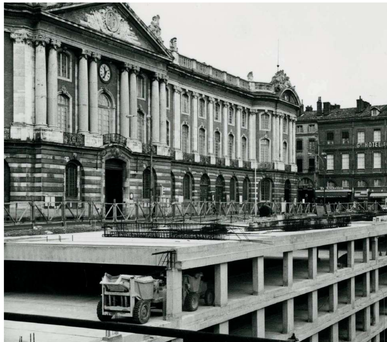
Construction view of the carpark below the Place du Capitole à Toulouse featuring 855 spots over 5 levels. Vue de la construction du parking situé sous la Place du Capitole à Toulouse, comprenant 855 places réparties sur 5 niveaux. Toulouse, 1971.
